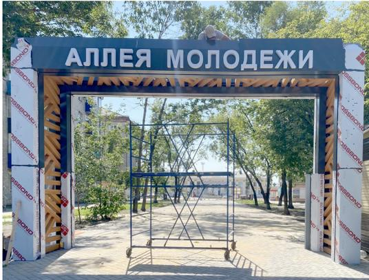
**Входные арки, выполненные в экостиле, установили на аллее Молодёжи. Конструкции с названием общественного пространства будут оборудованы подсветкой. Сейчас подрядчик выполняет монтаж электрооборудования.**
